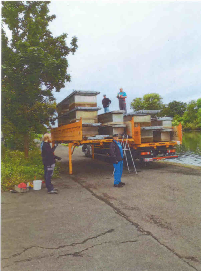
Die Stege auf unseren Wechselbrücken, wurden von Barfuß – Otto gefahren
